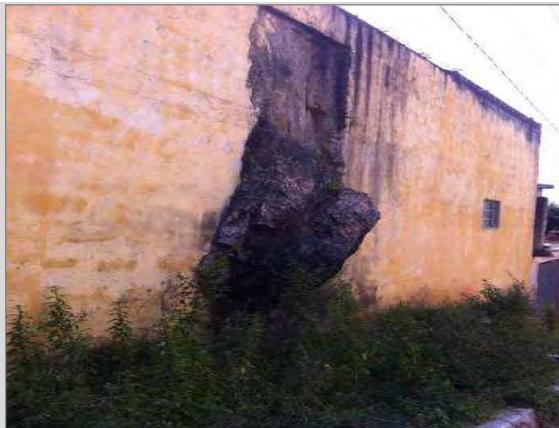
Foto 09 - Muro de residência adaptado ao afloramento de rocha granítica na Rua Marli, a 2,5 km a sudeste da ADA (Ponto 11) em Carapicuíba.
