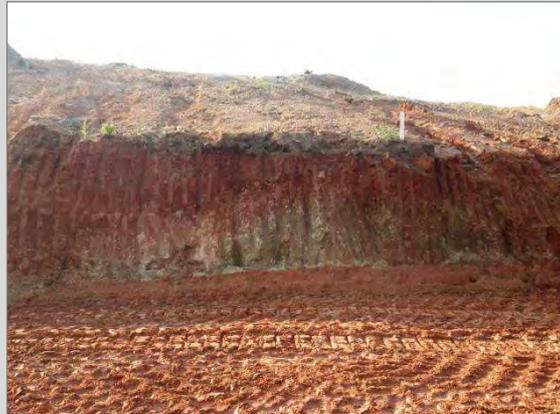
Foto 22 - Solo de alteração de rocha em corte para terraplanagem no Ponto 15, divisa entre Barueri e Carapicuíba.
