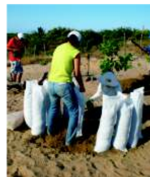
Enchendo os sacos com o barro reciclado, para a produção de Superadobe.
