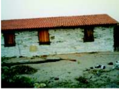
Casa edificada ainda sem o reboco.
