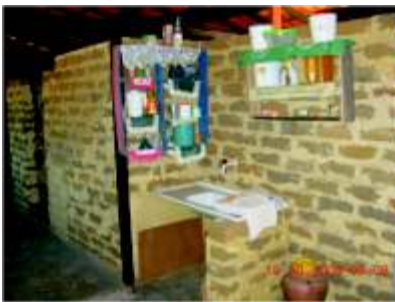
Paredes internas de Adobe, ainda sem reboco e pintura.
