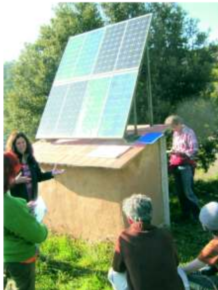
A Figura 65 mostra uma casinha de COB construída para instalar e abrigar as baterias de painéis fotovoltaicos (Permacultura Montsant, Espanha).
