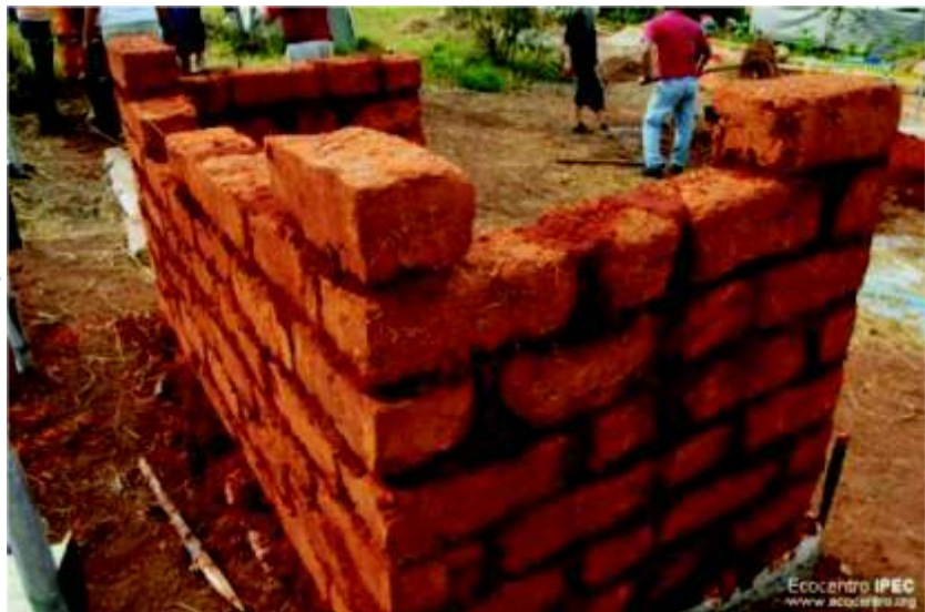
Figura 22: Tijolos de adobe: técnica tradicional utilizada em vários países, valorizada hoje em centros de pesquisa de tecnologias alternativas. Fonte: www.ecocentro.org Bioconstruindo 2005, Ecocentro IPEC.
