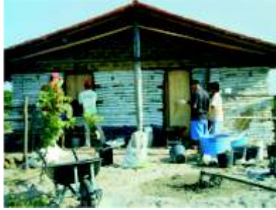
Instalação de portas e janelas.
