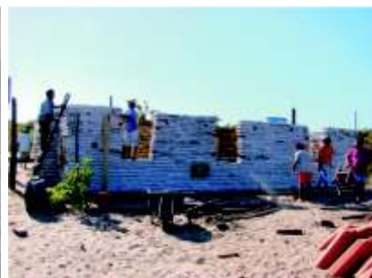
Construção das paredes externas.
