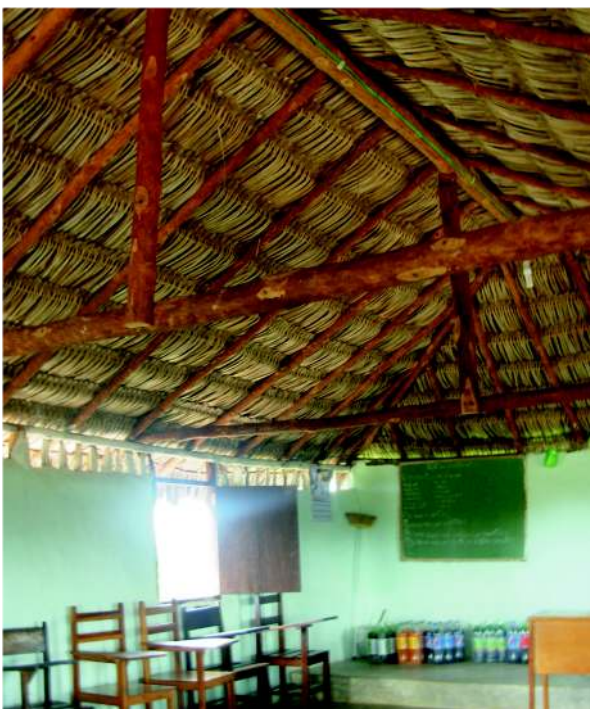
Figura 21: Telhado de palha na Ilha Grande do Paulino, Delta do Parnaíba: técnica valorizada em grandes centros urbanos. Beleza e conforto térmico.
