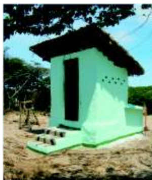
Vista lateral do sanitário seco.
