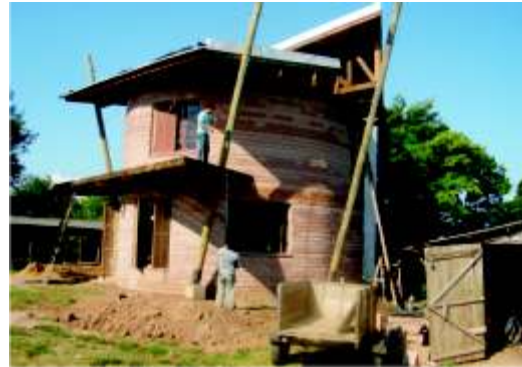
Figura 11: Residência bioconstruída com paredes de pedra arredondadas (Lomba Grande/RS)
