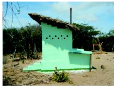
Vista lateral do sanitário seco.
