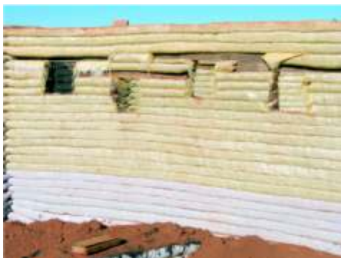
Figura 45: Com uma manilha podemos construir uma janela.
