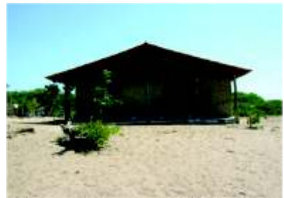
Vista frontal da casa com reboco concluído.
