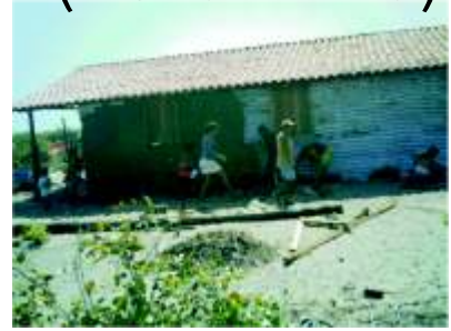
Colocação do reboco externo.
