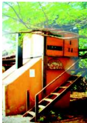
Figura 8: Sanitário seco no IPEC, em Pirenópolis: as fezes viram adubo. Neste foram usadas garrafas de vidro como janelas para iluminar o interior.
