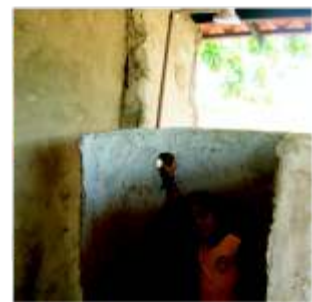
Vista do Box para banho.
