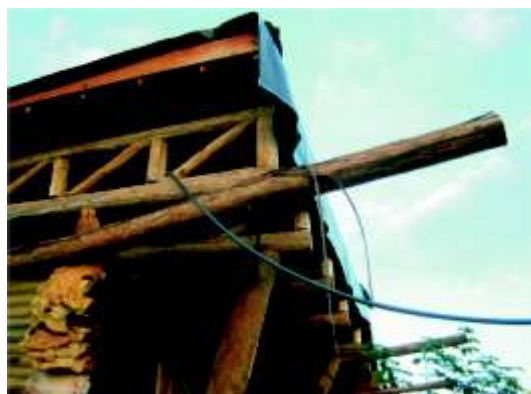
Figuras 16 e 17: Estrutura do telhado com madeira de eucalipto tratada com óleo natural (Montenegro/RS).
