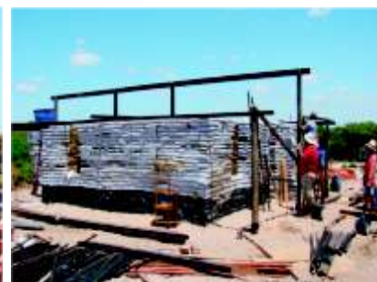
Construção da estrutura do telhado.
