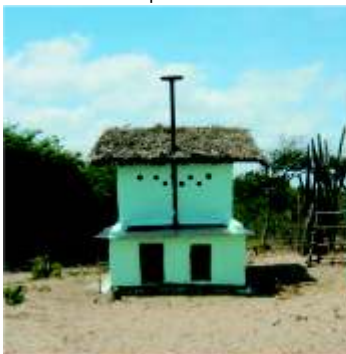
Vista posterior do sanitário seco.
