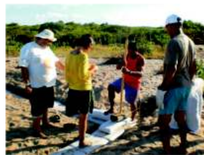
Trabalho em regime de mutirão para construção da fundação da casa.
