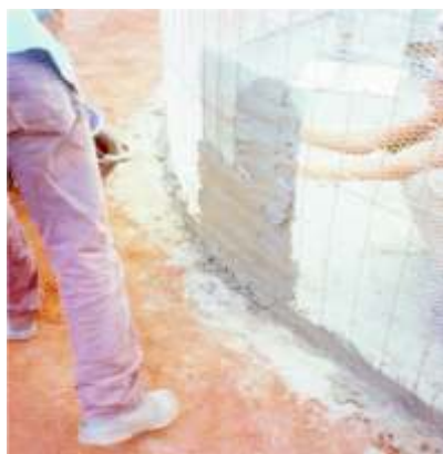
Figura 109: Enquanto um segura a placa metálica, outro aplica a massa. Foto: IPEC, Bioconstruindo 2002
