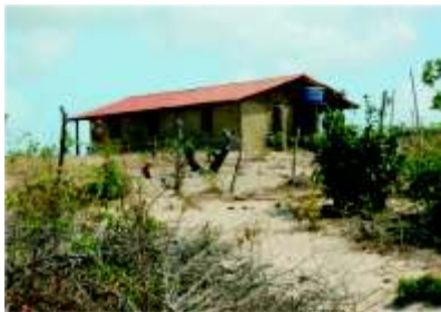
Vista lateral da casa com reboco concluído.
