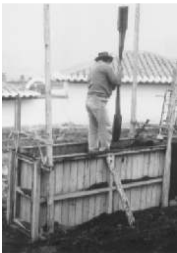
Figura 78: Socando com pilão de dois lados. Fonte: Manual de Construção com Terra, Gernot Minke
