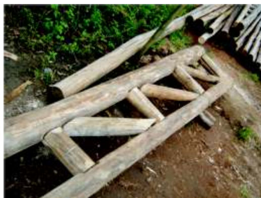
Figuras 16 e 17: Estrutura do telhado com madeira de eucalipto tratada com óleo natural (Montenegro/RS).
