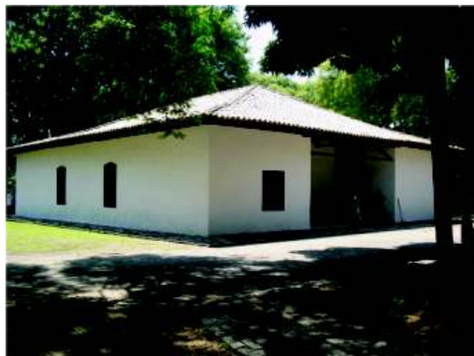
Figura 79: Foto: Marcelo Parize Petazoni (fonte: www.panoramio.com ) Casa do Bandeirante, Butantã, São Paulo. Construída no século XVII com paredes de taipa de pilão de 50 cm de espessura.
