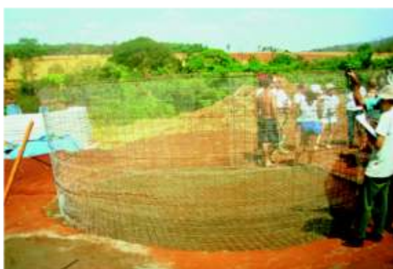
Figura 107: Cobrindo a base com cimento e areia. Foto: IPEC, Bioconstruindo 2002
