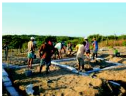
Trabalho em regime de mutirão para construção da fundação da casa.
