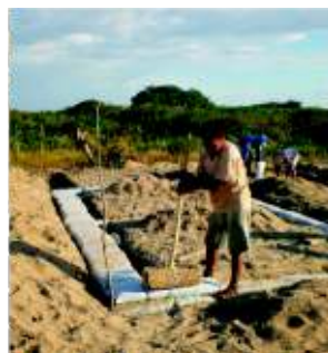
Fundação da casa - Técnica de Superadobe: Pilando os sacos.
